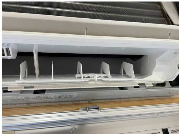
15.エアコンクリーニング
