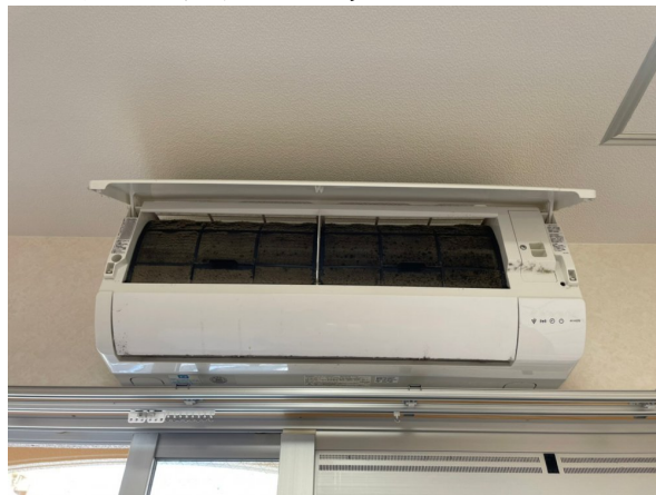
15.エアコンクリーニング
