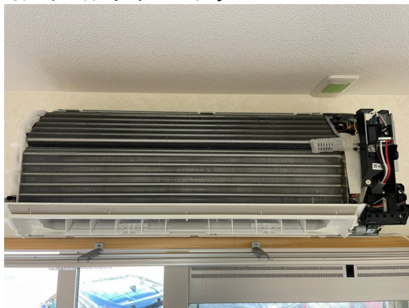
15.エアコンクリーニング
