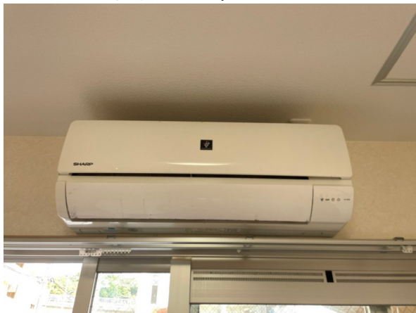
15.エアコンクリーニング
