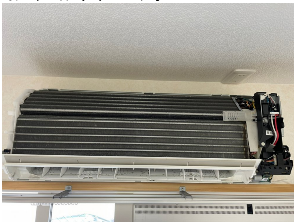
15.エアコンクリーニング
