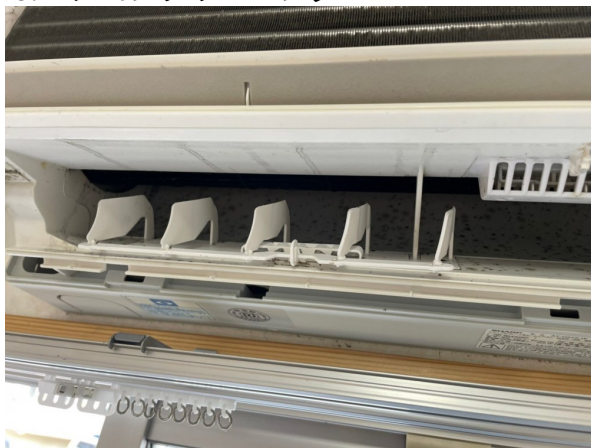
15.エアコンクリーニング
