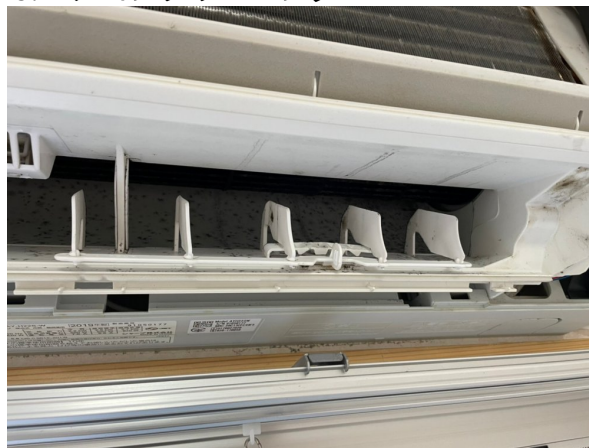
15.エアコンクリーニング
