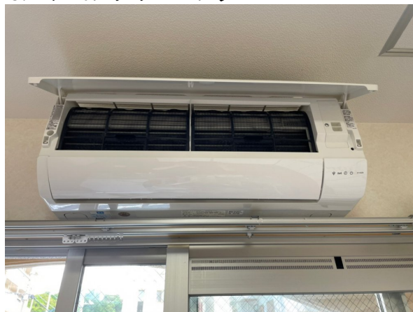
15.エアコンクリーニング
